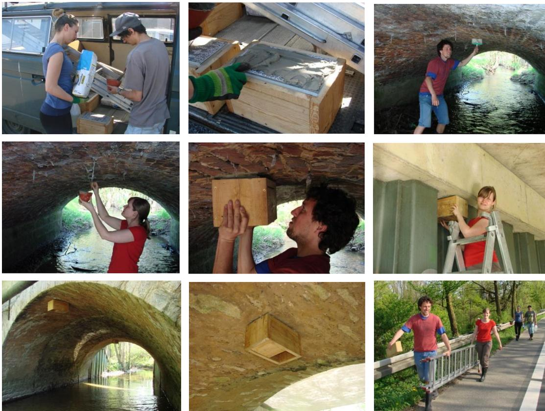
*So geht's: Vom schnell bindenden Fliesenkleber wird auf die Deckenfliese des Nistkastens eine ca. 1 cm dicke Schicht aufgetragen und auf die abgebürstete Gewölbedecke ebenso. Wenn dann mit etwas Kraft und Geduld eine halbwegs feste Verbindung entstanden ist, kann man vorsichtig loslassen und hoffen. Mit Glück hält das neue Quartier und man darf zum nächsten schreiten...*
